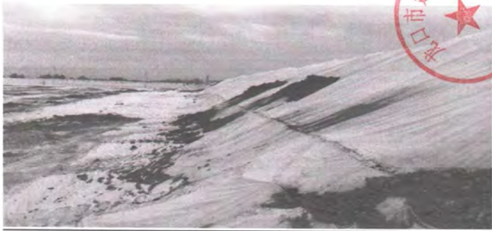
附图 3：土工膜施工图
