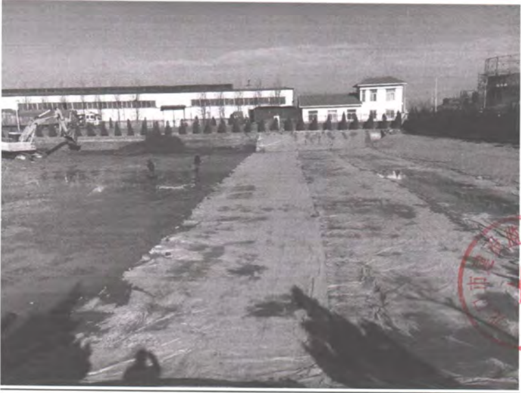
附图 3：土工膜施工图
